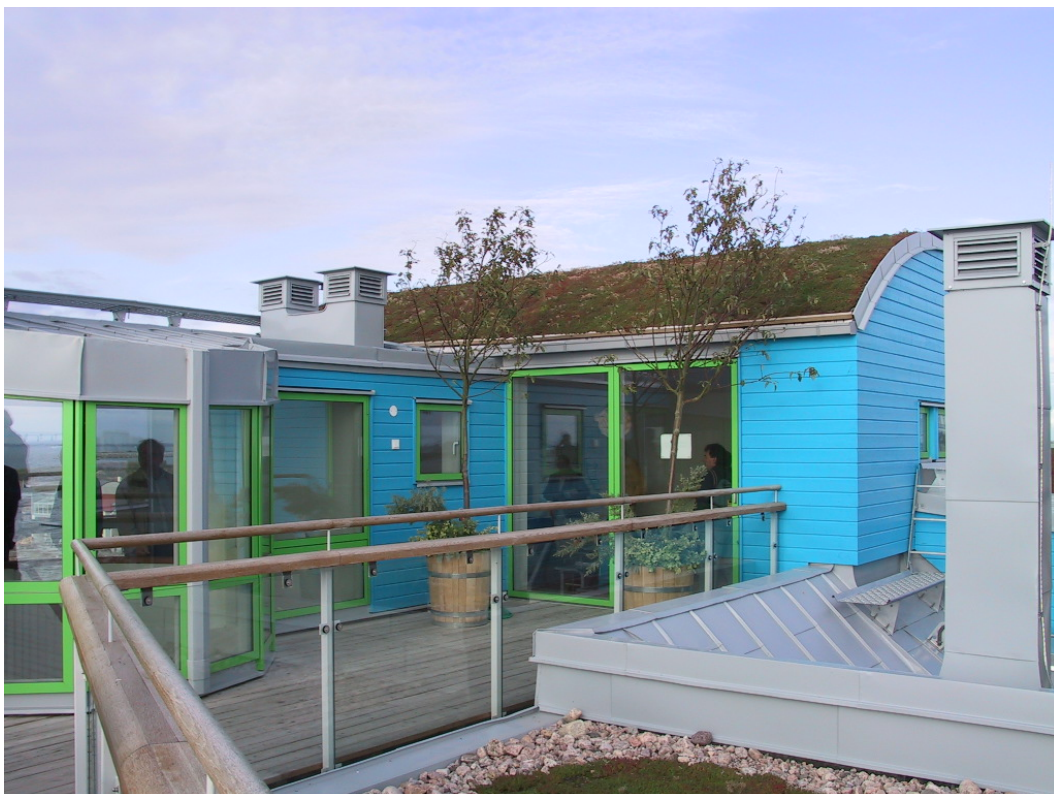
Fig. 01: pequenos pátios privados no terraço de multifamiliares, mas com todo o caráter de exteriores "térreos" – vista geral do edifício e vista do espaço exterior privado de uma habitação (no último piso do edifício) do conjunto urbano "Bo01 City of
