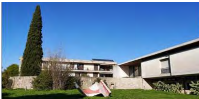
Figura 2 – Vista exterior do edifício
