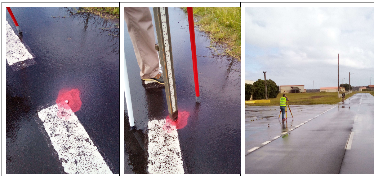
Figura 2.3 – Aspeto dos pontos de passagem e do seu nivelamento
