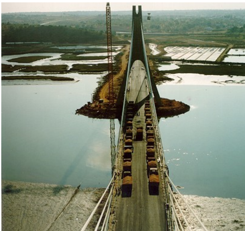
Figura 13 – Ensaio de carga da ponte do Arade [15]
