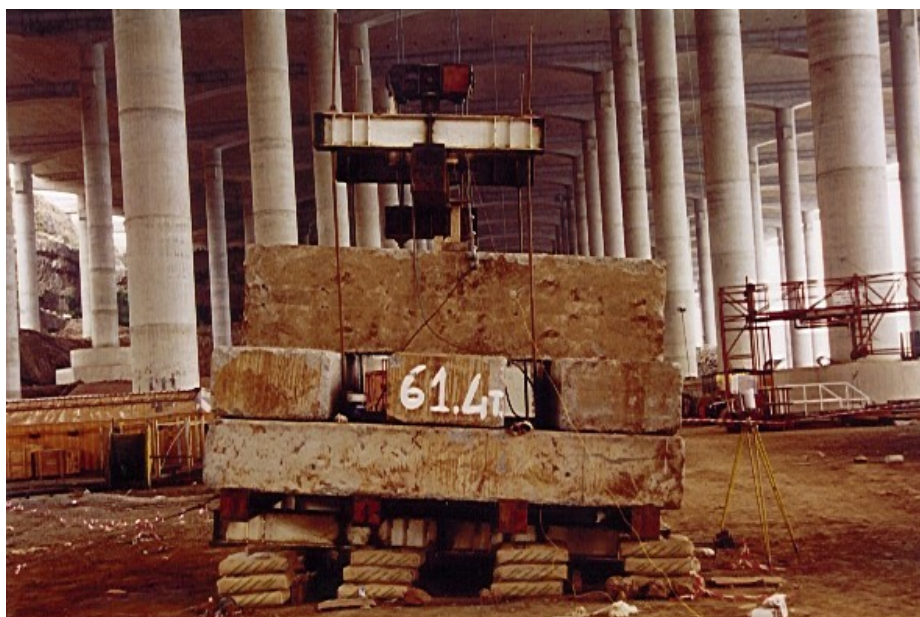
Figura 9 – Ensaio impulsivos no Aeroporto da Madeira: libertação de uma massa
