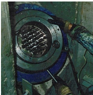
Figura 13 – Anel dinamométrico na medição da força instalada num tirante
