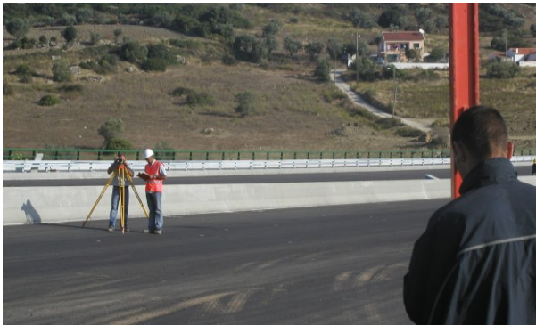
Figura 7 – Nivelamento do tabuleiro de um viaduto antes de um ensaio de carga
