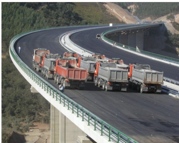
Figura 4 – Ensaio de carga do Viaduto sobre a ribeira da Vinha, na auto-estrada A2
