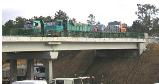
Figura 10: Carregamento de um tramo
