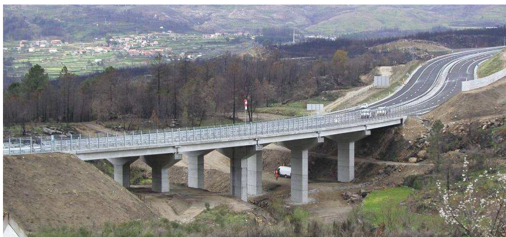
Figura 3: Vista geral da Ponte sobre o rio Felgueiras
