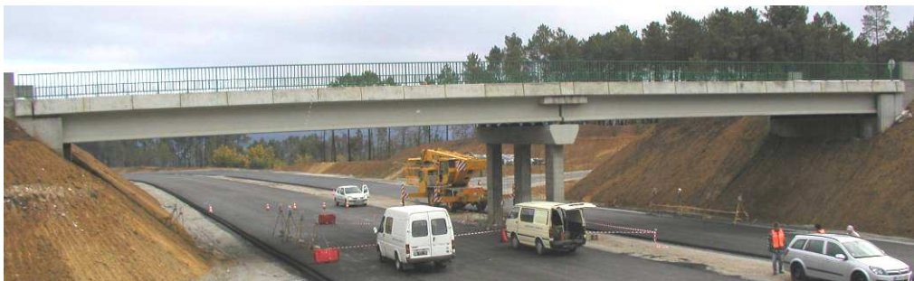
Figura 1: Vista geral da Passagem Superior 102
