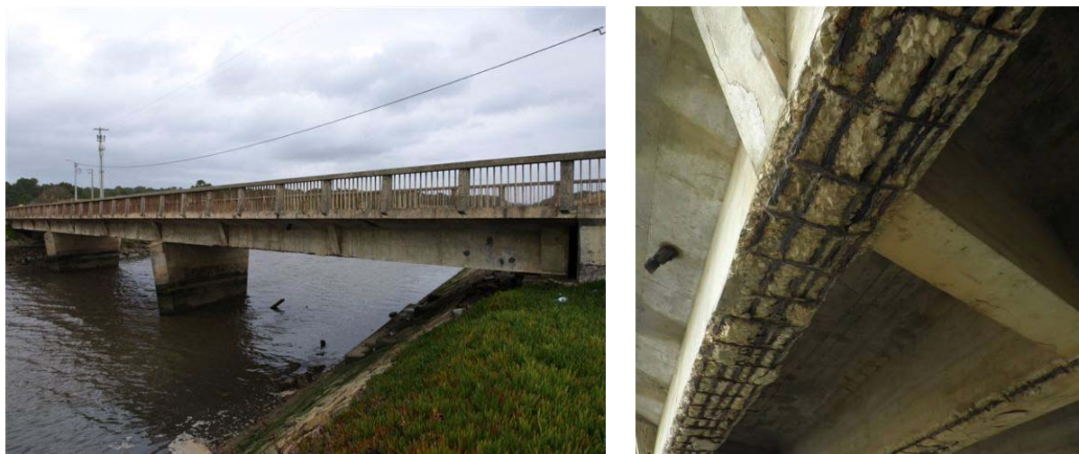
Figura 1. Vista de Sul para Norte da ponte objecto de estudo e vista inferior de uma das vigas.
