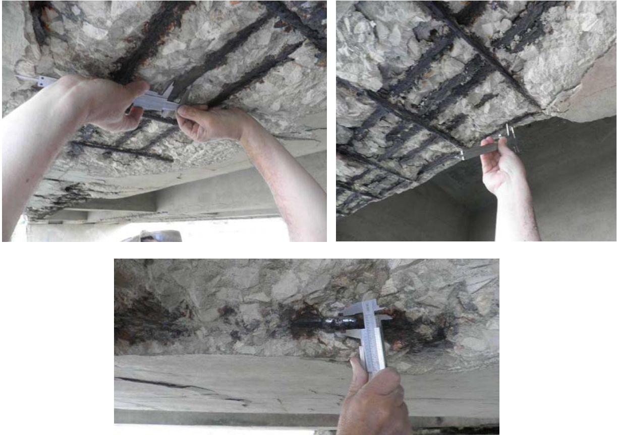
Figura 6. Medição de diâmetros armaduras em diferentes locais.
