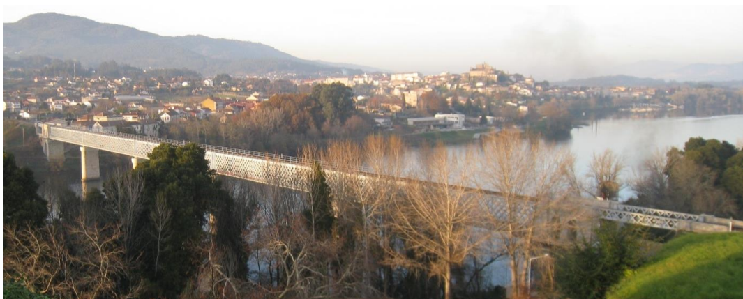
Figura 1. Ponte Internacional de Valença
