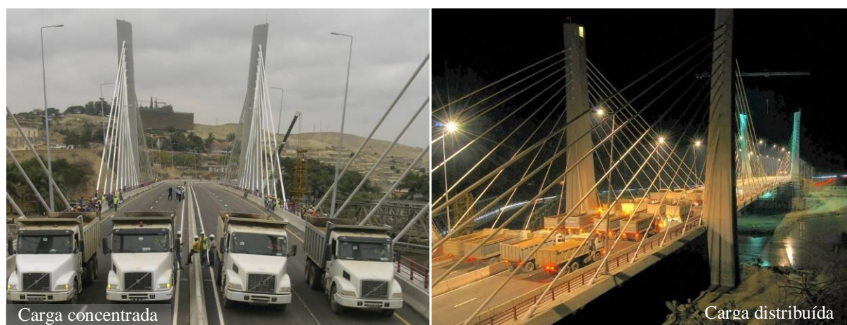
Figura 14 – Ensaio de carga estático da Ponte 4 de Abril, em Angola
