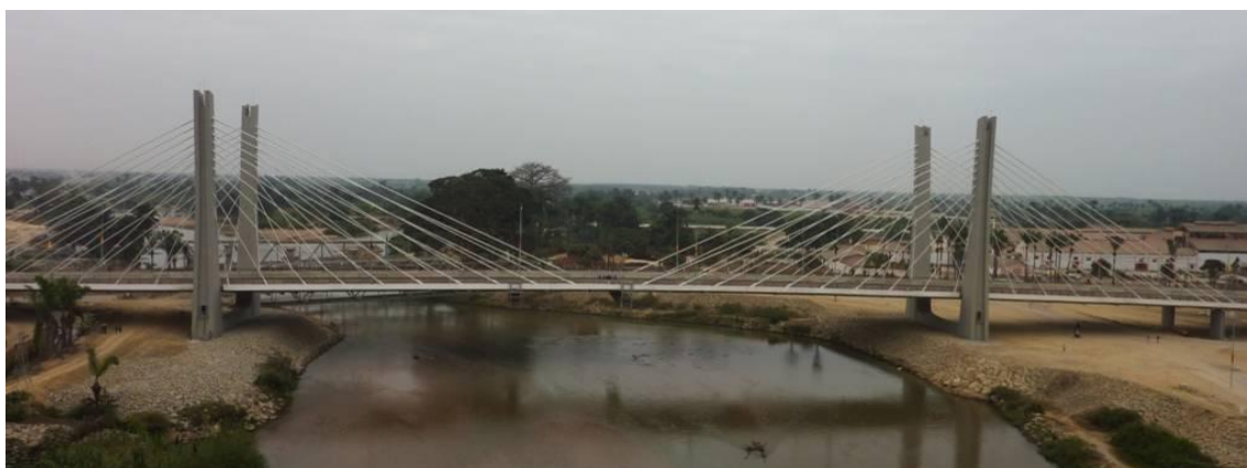
Figura 5 – Ponte 4 de Abril sobre o rio Catumbela, em Angola
