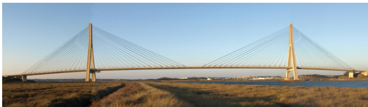
Figura 1 – Ponte Internacional do Guadiana
