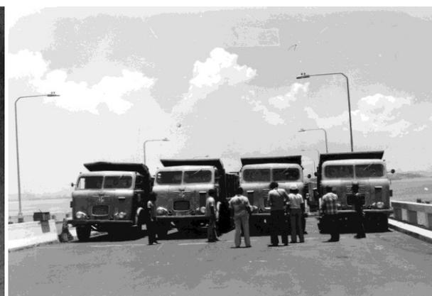
**Figura 3 – Ensaio de carga da Ponte Rio-Niterói**
