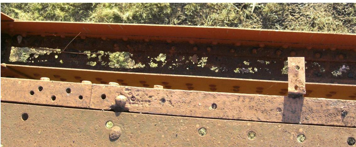
Figura 3 – Perfil com a alma destruída pela corrosão
