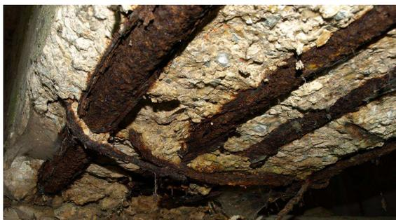
Figura 2 – Armaduras fortemente corroídas
