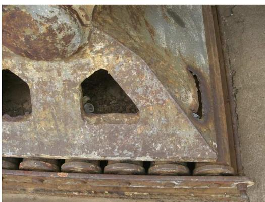
Figura 6 – Corrosão num aparelho de apoio
