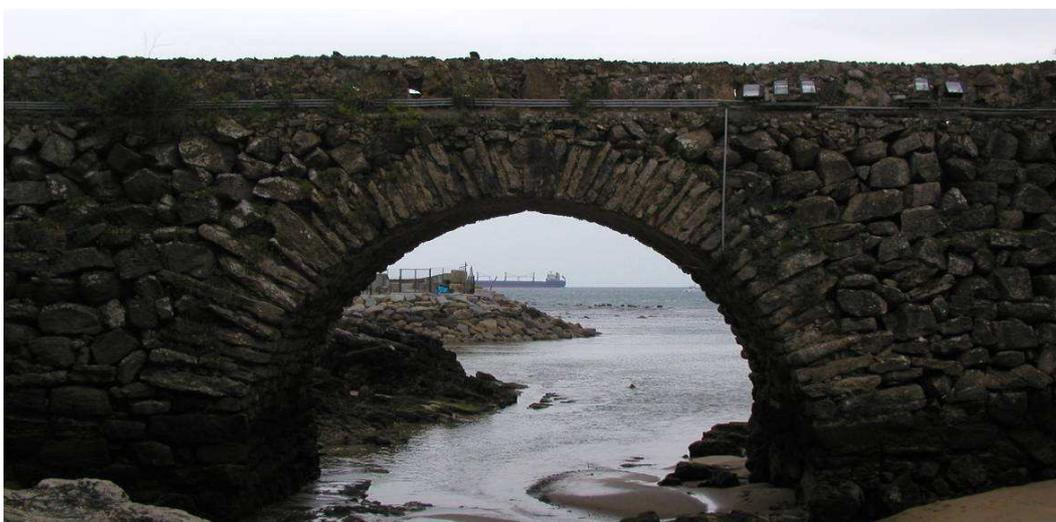
Figura 4 – Deficiente preenchimento das juntas dos blocos de alvenaria
