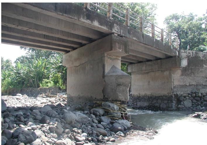
Figura 7 – Erosão junto ao pilar e encontro
