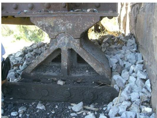
Figura 5 – Aparelho de apoio bloqueado
