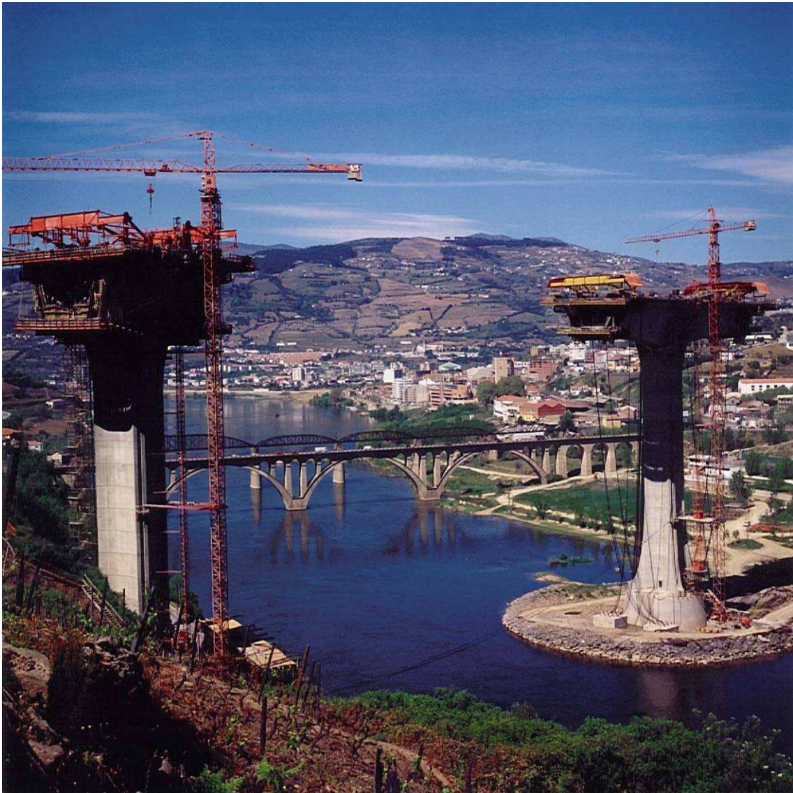
Figura 6 - Ponte Miguel Torga durante a construção pelo método dos avanços sucessivos
