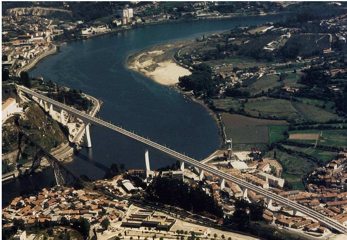
Figura 15 – Ponte de São João. Vista de jusante
