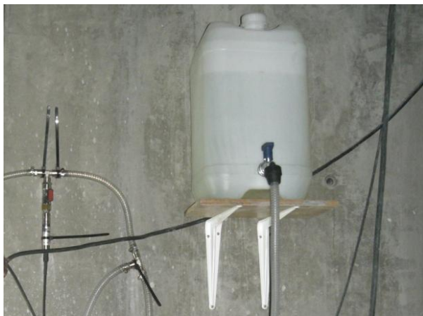
Figura 4 – Célula de pressão e depósito no topo do pilar P7
