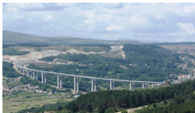
Figura 1 – Vista geral do Viaduto de Vila Pouca de Aguiar
