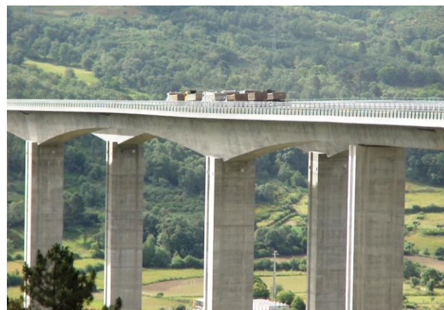
Figura 3 – Comboio de cargas durante os ensaios
