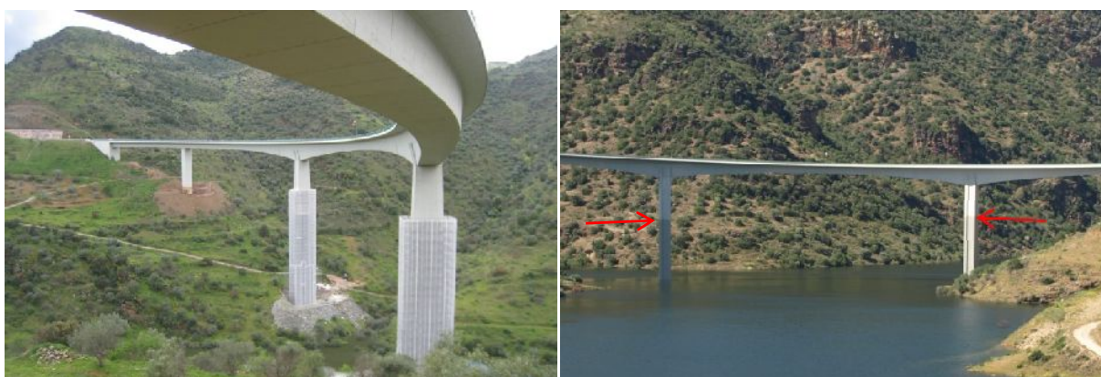
Fig. 3 – Vista da ponte durante e após os trabalhos de impermeabilização. As setas na imagem à direita indicam a cota máxima de aplicação do revestimento.
