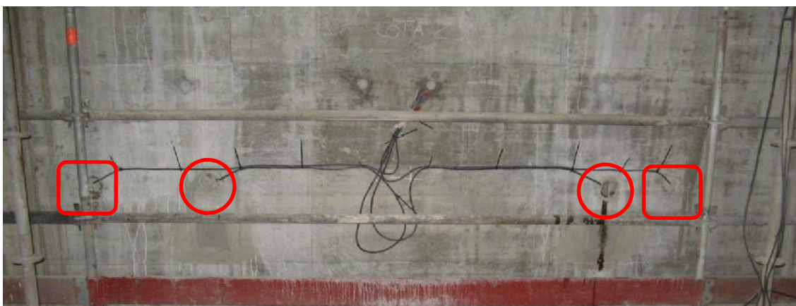
Fig. 6 – Aspeto da localização das carotes instrumentadas na secção S2 (cota 230 m)
