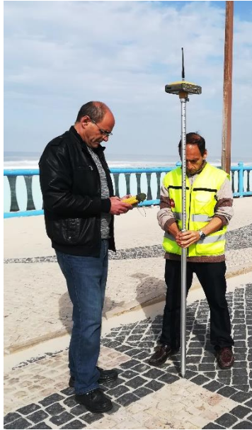
Figura 2.13 – Praia de Vieira: coordenação do canto de uma passadeira
