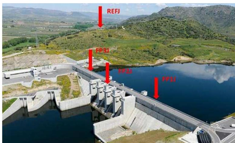
Figura 4. Barragem do Feiticeiro. Localização da estação remota e das estações GNSS no coroamento
