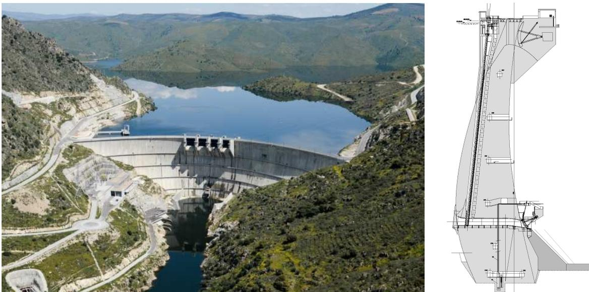
Figura 1. Barragem do Baixo Sabor. Vista de jusante (à esquerda) e corte vertical pela consola central (à direita)
