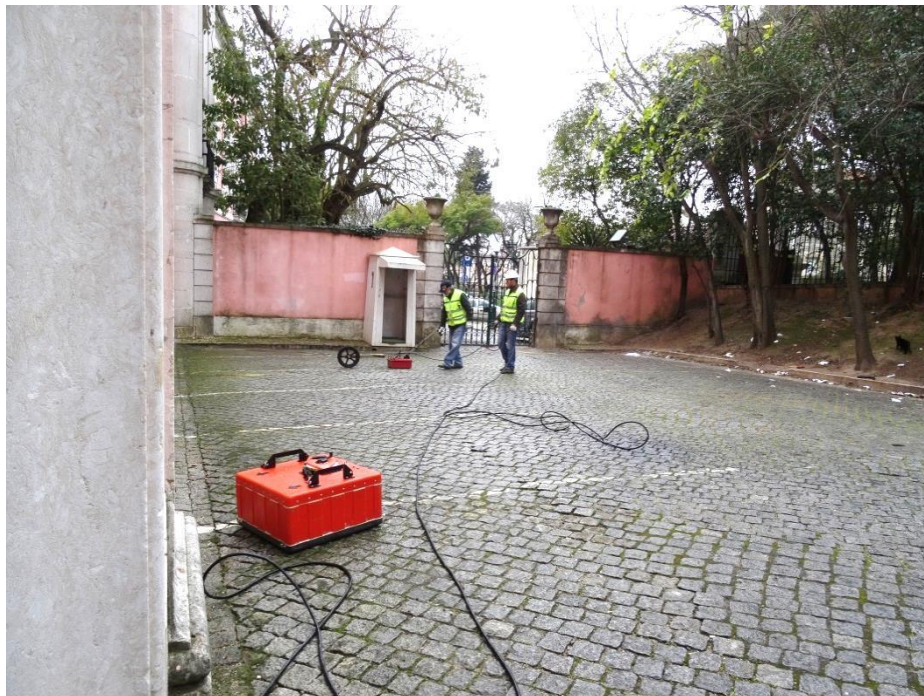
Figura 4 – Vista da execução de um perfil transversal
