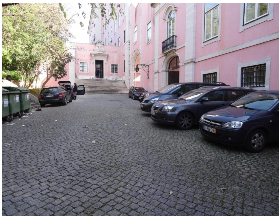
Figura 1 – Vista do pátio de acesso ao Palácio das Necessidades. Local onde se realizou a prospeção
