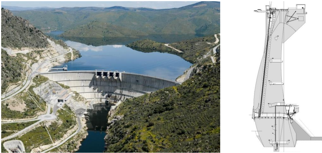
Figura 1. Barragem do Baixo Sabor. Vista de jusante (à esquerda) e corte vertical pela consola central (à direita)
