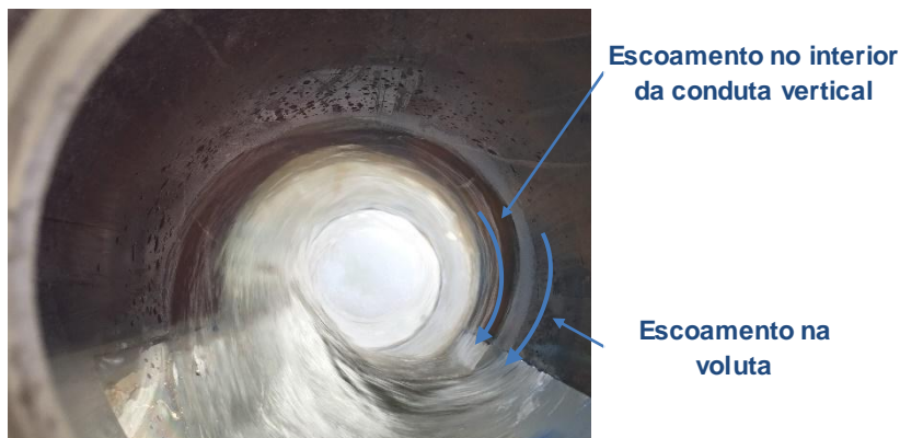
Figura 3. Vista do topo da conduta de queda vertical (caudal de 11 \text{ m}^3/\text{s} )
