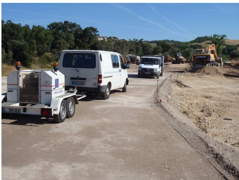
Figura 3.1 – Trecho experimental onde foram aplicados RCD
