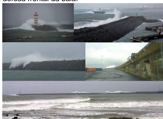
Figura 27. Estado do mar e galgamento na baía da Praia da Vitória a 15 de janeiro de 2016. As fotografias foram tiradas entre as 9h e 12h.
