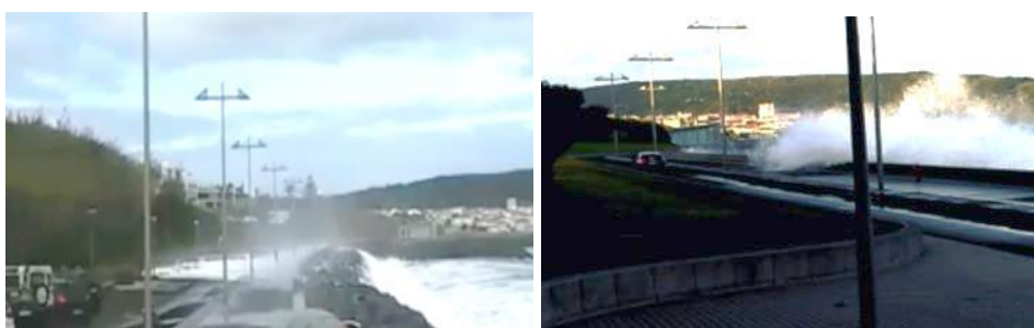
Figura 21. Galgamentos na baía da Praia da Vitória a 1 de novembro de 2015.
