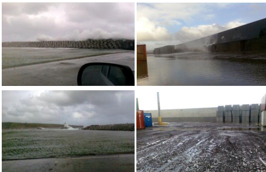
Figura 11. Galgamentos no quebra-mar sul da Praia da Vitória em 24 de janeiro de 2007
