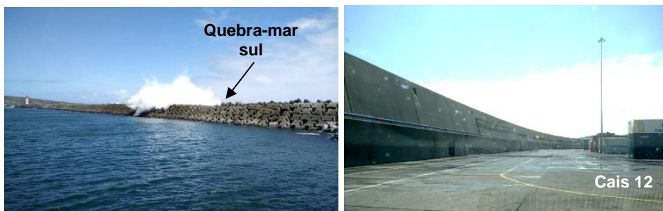
Figura 32. Galgamentos no quebra-mar sul durante a tempestade de 27 de abril de 2017
