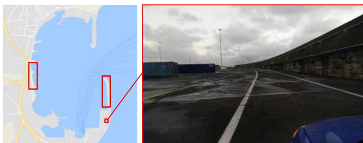
Figura 30. Identificação pelas autoridades das secções afetadas pelo galgamento
