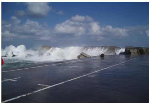
Figura 10. Galgamentos no quebra-mar sul da Praia da Vitória no dia 27 de fevereiro de 2005. (Fotografia: Diário Insular)
