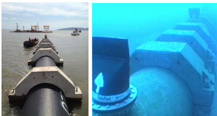
Figura 1 – Emissários submarinos: Conduta e anéis.
