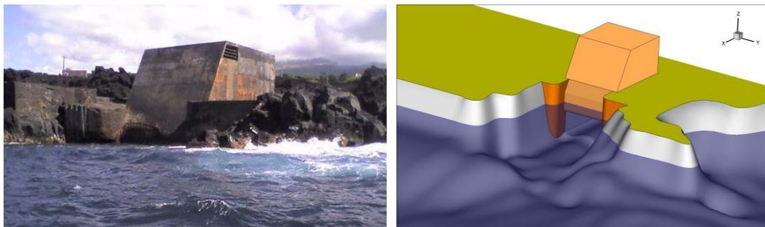
Figura 8 – Central de energia das ondas de Porto Cachorro, Pico, Açores, e modelo numérico do dispositivo no tanque 3D de ondas.
