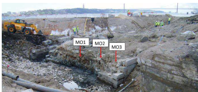
Figura 4: Locais de recolha de amostras no núcleo do Cais das Colunas. Alçado nascente, 2008.
