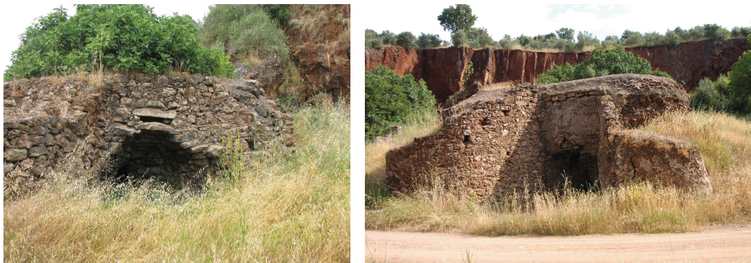
Figura 2: Fornos de cal da região da Escusa, construídos em alvenaria de pedra seca ou assente em argamassa, de formato circular, à semelhança dos que também se encontram em Porto da Espada.
