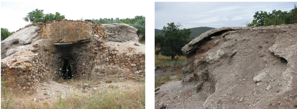
Figura 5: Exemplo de fornos de cal da região de Porto da Espada e pormenor do capelo.
