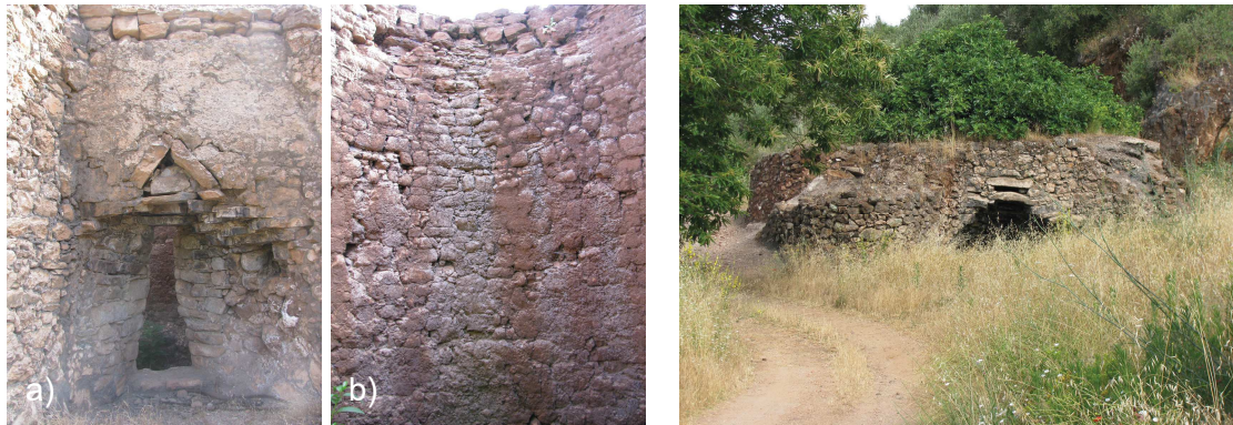
Figura 4: Exemplos de fornos de cal da região de Olhos de Água: a) Porta do forno; b) Interior do forno.
