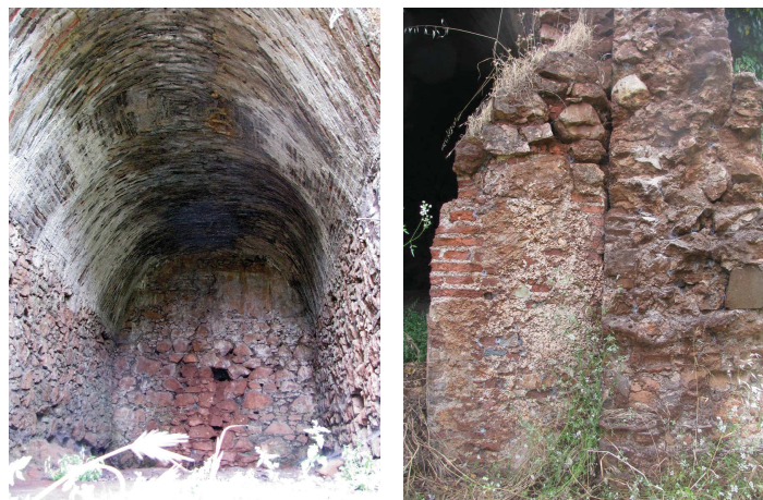
Figura 3: Forno de cal, construído em alvenaria de tijolo e pedra irregular assente em argamassa, Olhos de Água. À direita, pormenor das paredes onde se recolheram as amostras A3 e A4.
