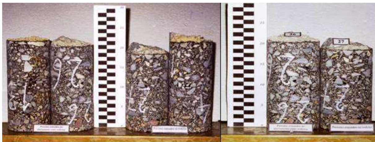
Figura 6.7 – Aspectos de alguns dos tarolos recolhidos do pavimento do IP7/A6
