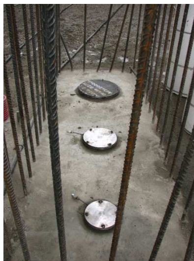
b) Vista do posicionamento dos macacos planos não acessíveis numa das células de fluência da barragem do Baixo Sabor
