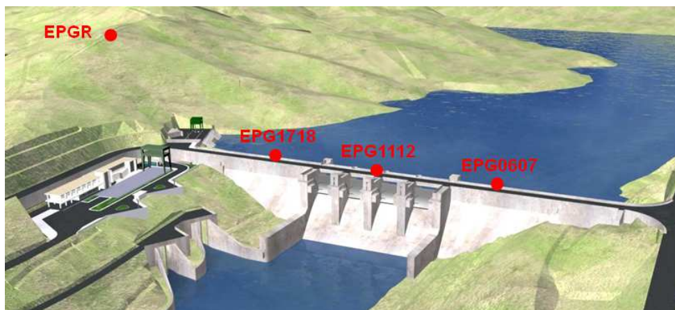
Figura 5: Localização das quatro antenas GNSS na barragem do Feiticeiro
