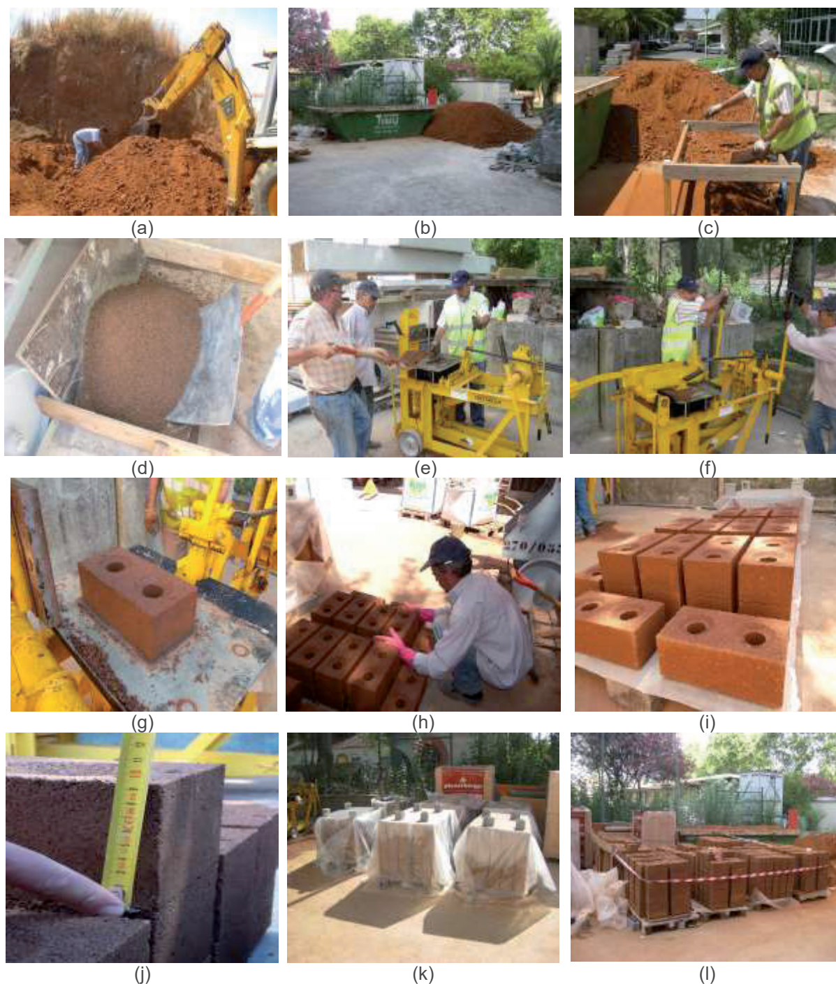
Figura 5: Processo de Produção dos BTC: (a) recolha das terras no Alentejo; (b) terras no LNEC; (c) peneiração da terra; (d) preparação da mistura para a compressão; (e) colocação da mistura no molde; (f) compressão do bloco (g) bloco final; (h) colocação do bloco em paletes; (i) blocos na palete; (j) controlo das dimensões; (k) cura durante os primeiros 7 dias sob um filme de polietileno; e (l) cura por processo de secagem ao ar até aos 28 dias de idade.
