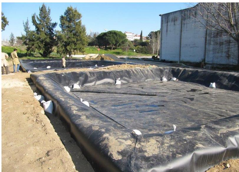
Fig. 6 - Aspeto da fase de construção da instalação piloto
