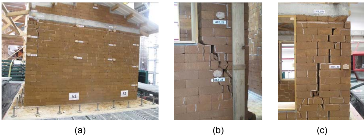
Figura 8. Dano observado no modelo: (a) parede Sul; (b) nembro da fachada principal junto à porta de entrada; (c) cunhal Sudoeste.
