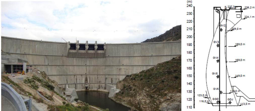
Figura 4: Vista de jusante da barragem do Baixo Sabor e corte vertical pela consola central
