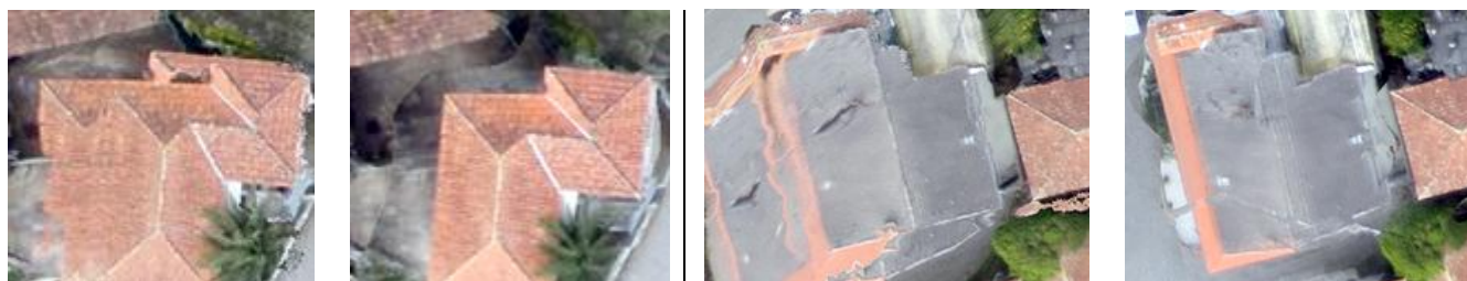
Figura 15 – Telhados de estruturas em ortomosaicos gerados por versões diferentes do mesmo software
