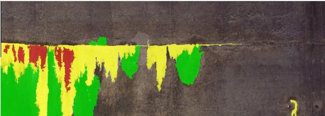
Figura 15 – Identificação automática de ocorrências por classificação orientada por objetos. Significado das cores: verde – betão molhado; amarelo – carbonato de cálcio com cor branca; vermelho – carbonato de cálcio com cor castanha
