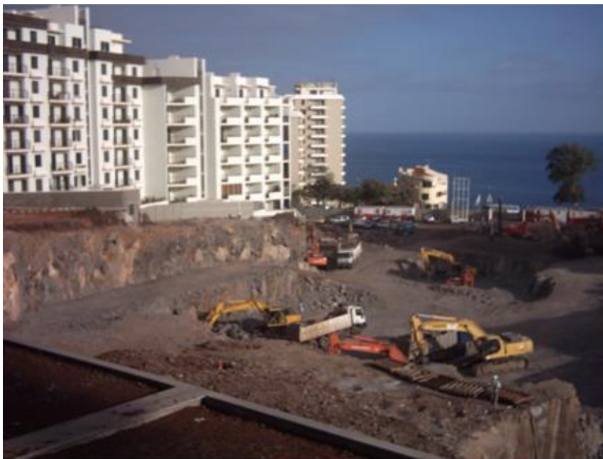
Figura 4.1 – Escavação onde foram utilizados explosivos e máquinas de escavação/demolição
