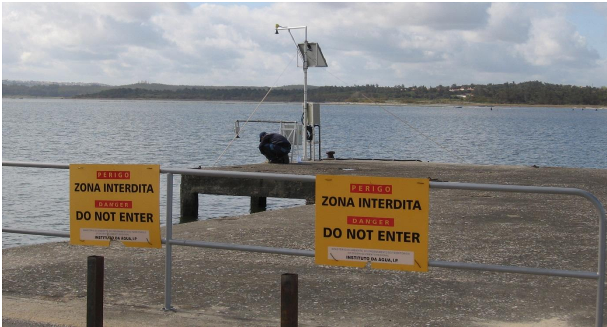
Figura 3.8 – Marégrafo instalado no Cais da Foz do Arelho
