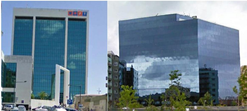
Figura 1 – Exemplo de edifícios de escritórios em Lisboa com fachada-cortina de alumínio e vidro
