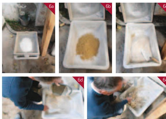
6. Preparação das argamassas de cal. a. Peneirar a cal viva micronizada; b. Misturar a areia; c. Misturar a cal e areia; d. Juntar água; e. Misturar tudo.
