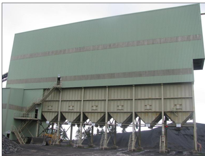
Figura 5.10 – Unidade de britagem da pedra, automatizada, com seis silos
