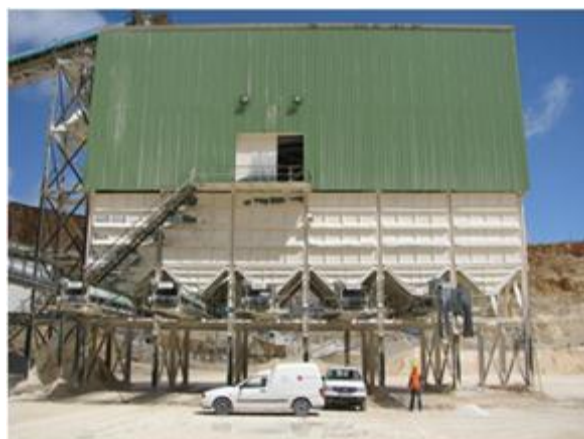
b) Central de britagem
