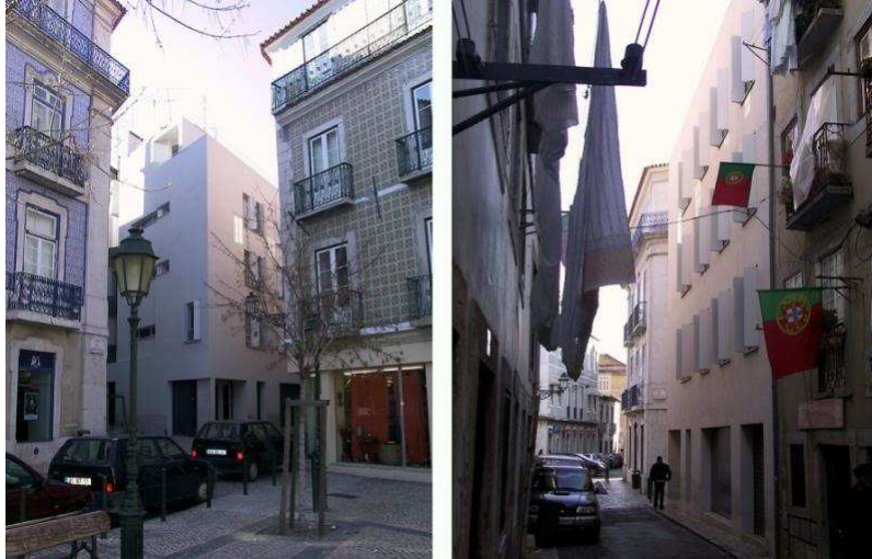
Fig. 05: Um bom exemplo de introdução de um moderno pequeno edifício de habitação de interesse social de promoção municipal num velho bairro de Lisboa, junto ao Largo do Conde Barão, edifício com projeto de Eugénio Castro caldas e Nuno Távora (2005).
