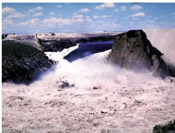
Fig. 43 -Rutura da barragem de Teton nos Estados Unidos
