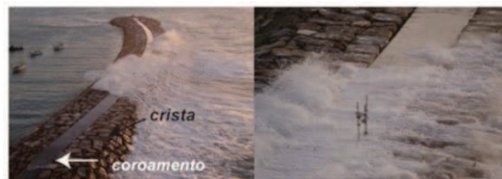
Fig. 2. Galgamento do quebra-mar poente do Porto de Albufeira durante a recolha de dados no dia 19 de Janeiro de 2013.
