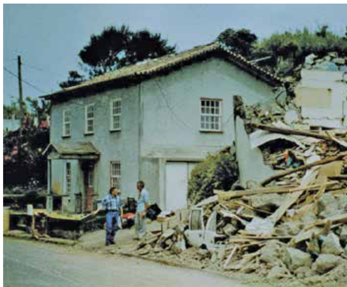
Figura 4 – Diferença de resistência sísmica entre construções [8].
