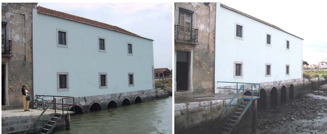
Fig. 6.7 – Tide-mill (N façade)
