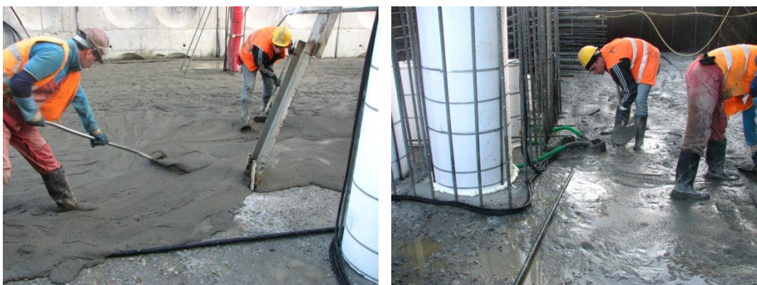
Figura 4.12 – Enchimento da conduta técnica com argamassa
