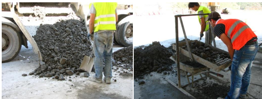
Figura 4.4 – Chegada do betão ao cais de baldes (esquerda) e crivagem do betão integral (direita).
