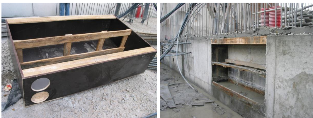
Figura 4.7 – Execução de nicho em galeria: módulo de cofragem (à esquerda) e aspeto do nicho durante a descofragem (à direita)
