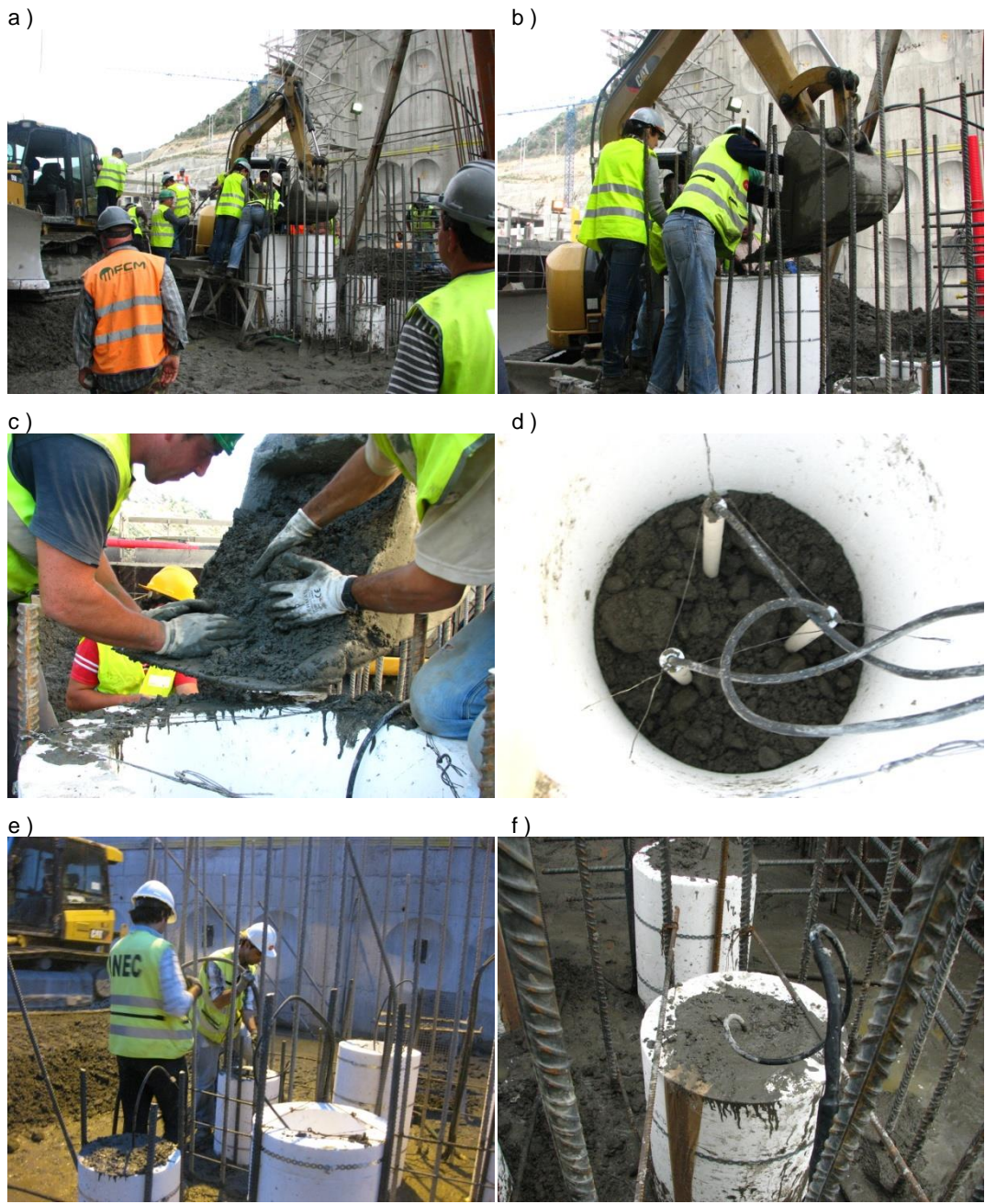
Figura 4.14 – Aspectos da colocação do betão nos moldes das células de fluência
