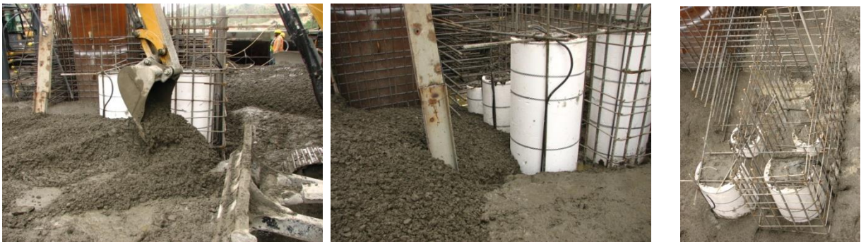
Figura 4.15 - Betonagem da envolvente das células de fluência
