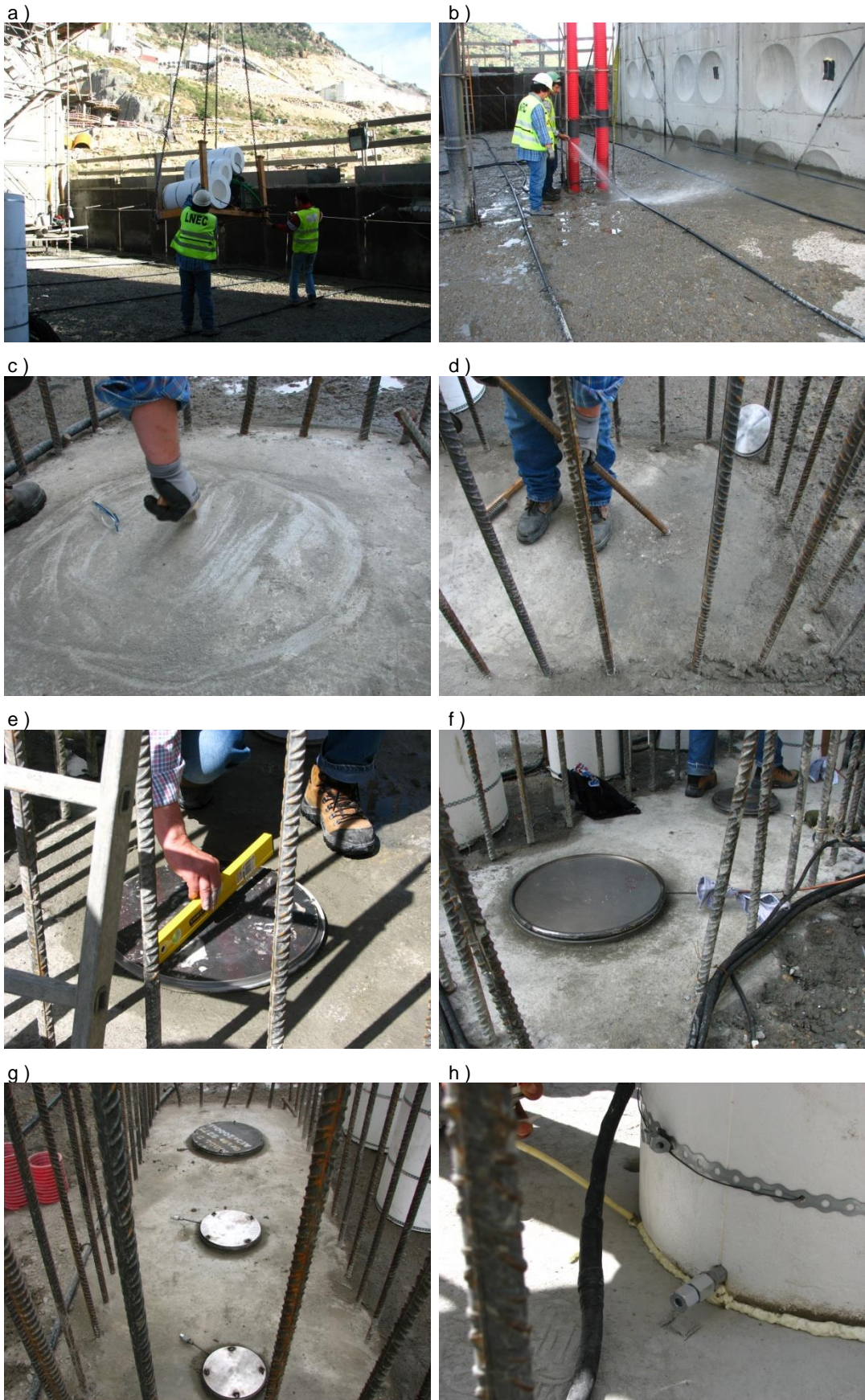
Figura 4.10 – Trabalhos preparatórios de instalação dos moldes de EPS
