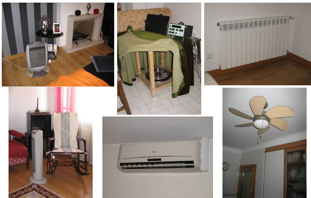
Figura 2: Tipos de equipamentos de climatização existentes nos espaços estudados
