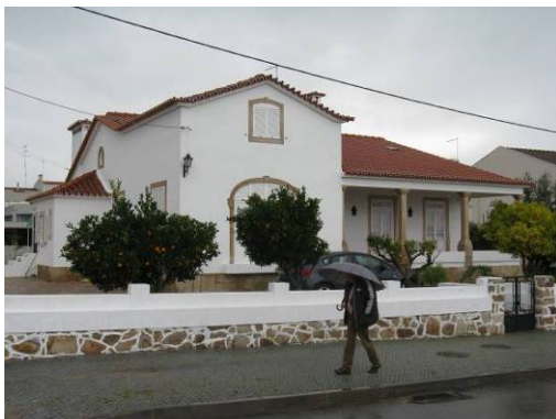
a) Edifício de 1957
