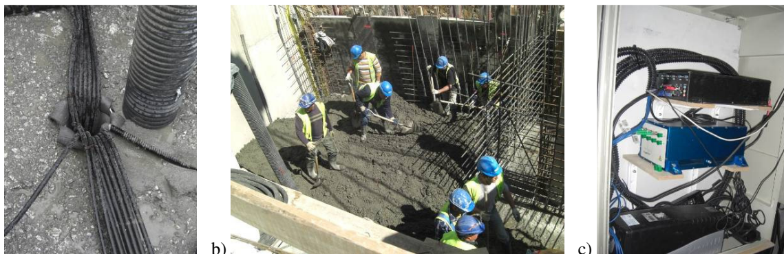
Figura 9. Detalhes da instalação em obra: contraste entre conjunto de cabos elétricos e a simples conduta ótica, a); betonagem junto aos sensores, b); posto de aquisição do sinal ótico, c).
