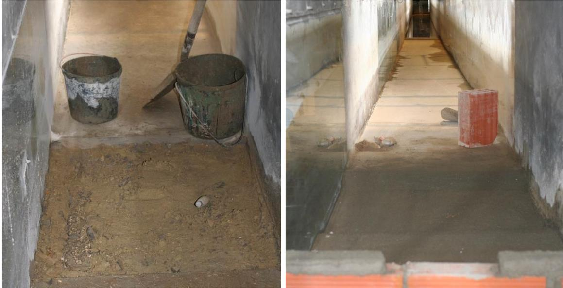
Figura 3-8 – Aspeto da construção da escavação destinada à fundação do pé do perfil
