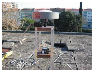
Figura 8 – Instalação dos acelerómetros Kinematics uni-axiais e da antena GNSS no edifício de 3 pisos.
