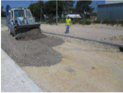
Figura 5.34 | Espalhamento do material granular
