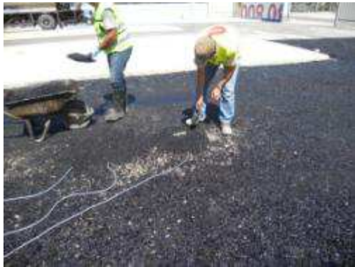
Figura 5.39 | Instalação dos extensómetros horizontais na base da camada betuminosa
