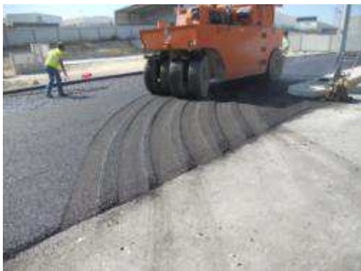
Figura 5.40 | Compactação da camada betuminosa
