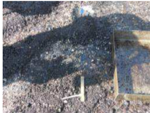
Figura 5.39 | Instalação dos extensómetros horizontais na base da camada betuminosa
