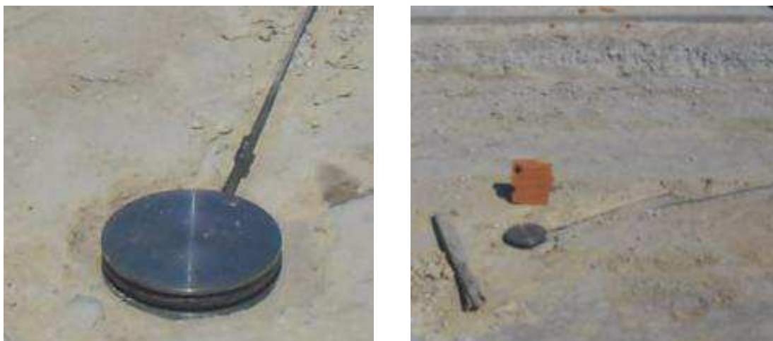
Figura 5.46 | Implantação da célula de pressão
