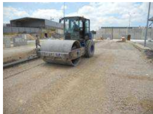
Figura 5.35 | Rega e compactação da camada granular
