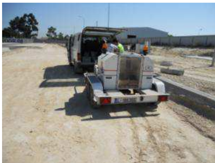
Figura 5.42 | Equipamento FWD do LNEC em ensaio
