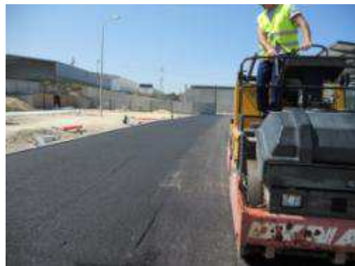
Figura 5.40 | Compactação da camada betuminosa
