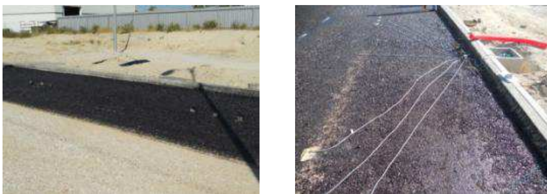
Figura 5.38 | Trabalhos preparatórios para a aplicação da camada betuminosa
