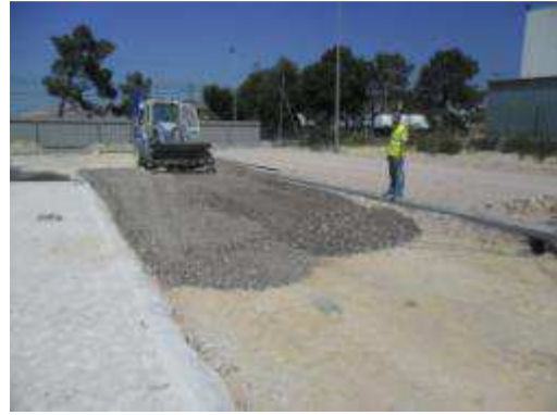
Figura 5.34 | Espalhamento do material granular
