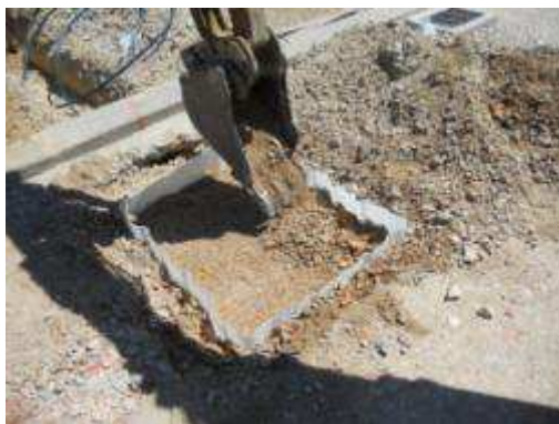
Figura 5.36 | Construção de lisímetro no trecho experimental
