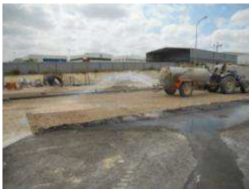
Figura 5.35 | Rega e compactação da camada granular
