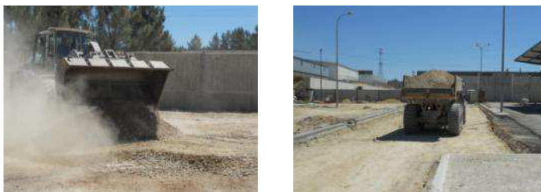
Figura 5.33 | Mistura e transporte dos materiais a aplicar nos trechos experimentais
