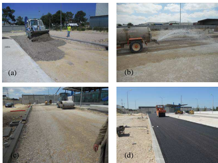
Fig. 4. Diferentes fases da construção do trecho piloto
