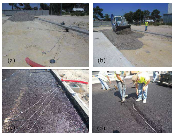
Fig. 6. Instrumentação das secções experimentais, no topo do aterro de fundação e na base da camada betuminosa
